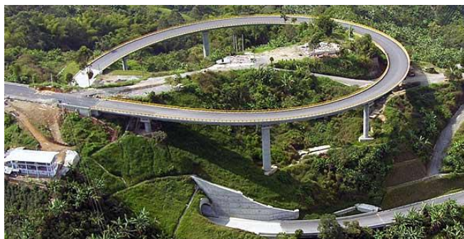
Figura 6. Puente Helicoidal Dosquebradas, Colombia.
